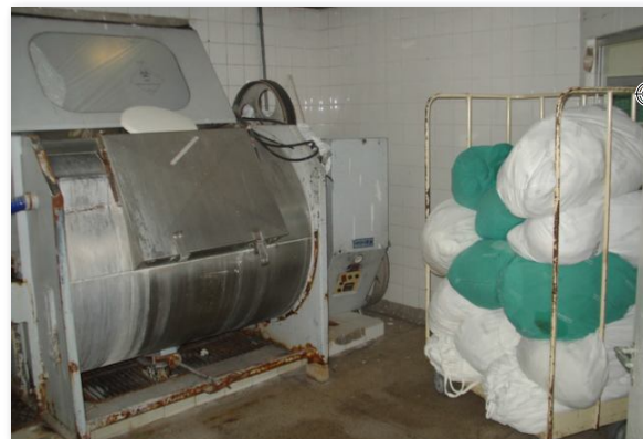
Diversas unidades de saúde apresentam infrações e falta de manutenção dos equipamentos. Todos os casos foram denunciados às autoridades competentes para que os problemas sejam sanados o mais breve possível
