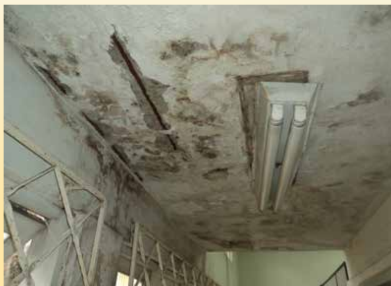
No Hospital Cassiano Antônio de Moraes (Hucam) há ferrugem exposta no corredor do ambulatório
